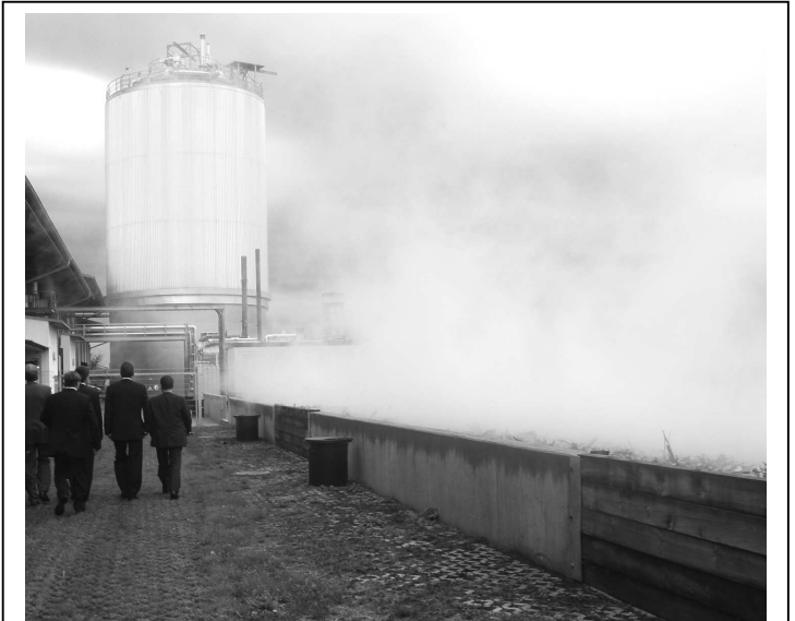
Fermenter zur Biogaserzeugung
