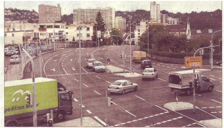
Nichts erinnert mehr an die großangelegte Baustelle an der Geze-Kreuzung. Foto: factum/Granville
